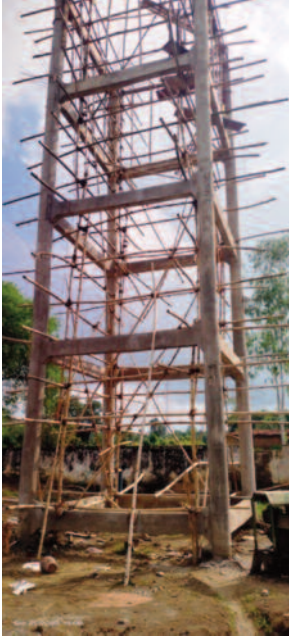
दर है इसकी जानकारी ग्रामीणों को नहीं मिली है और ठेकेदार पानी टंकी का निर्माण कार्य पूरा किया जा रहा है।
